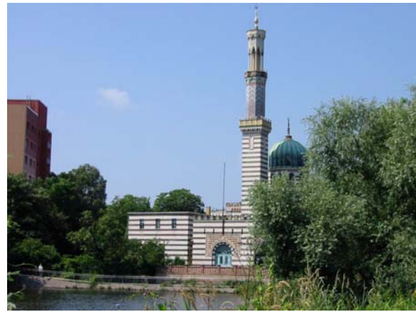
Steam Engine (Dampfmaschinenhaus)
